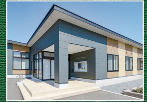
駐車場の整備が完成し、会館の建替え事業が完了しました
